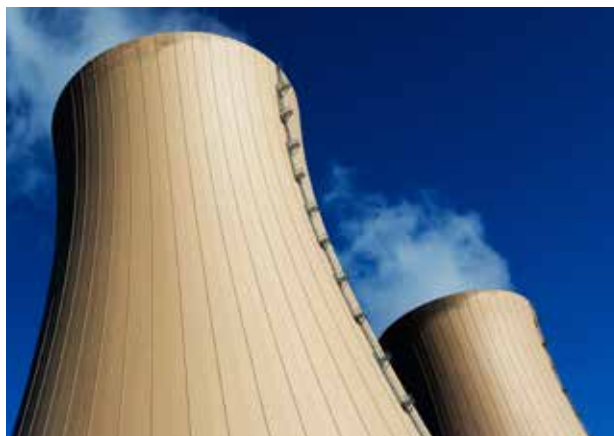
Centrale nucléaire : aéroréfrigérants
