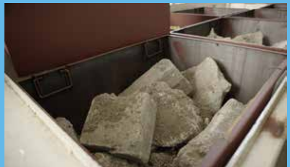
Déchets gravats issus de démantèlement
